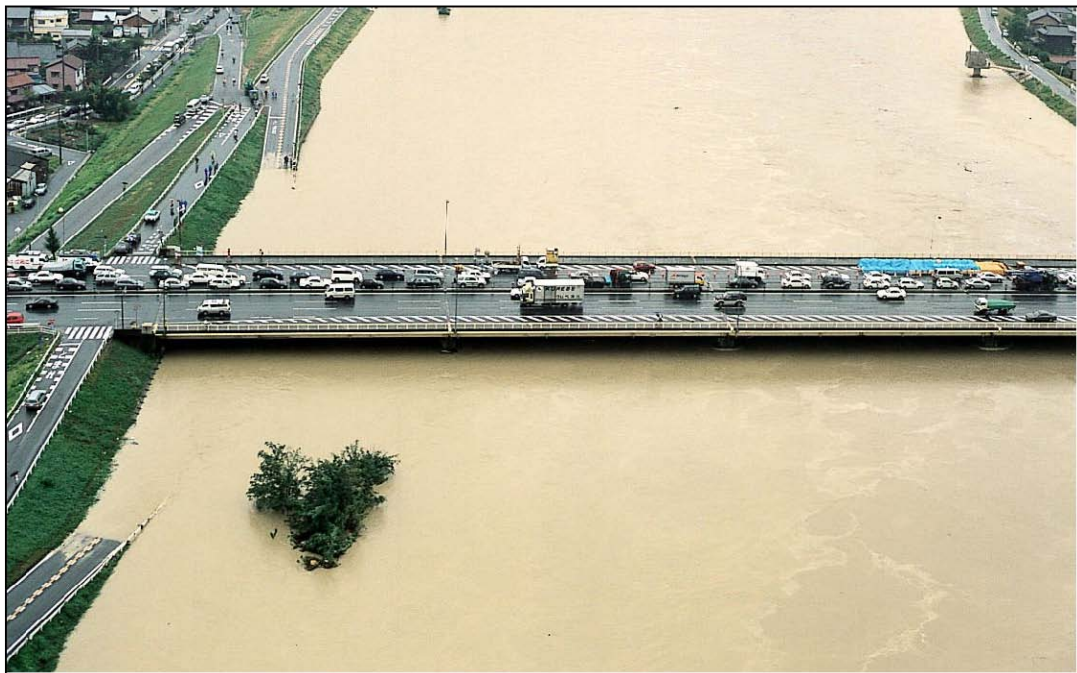
東海豪雨時における新名西橋堤外アンダーパスの水没(庄内川左岸 16.0k 付近)
