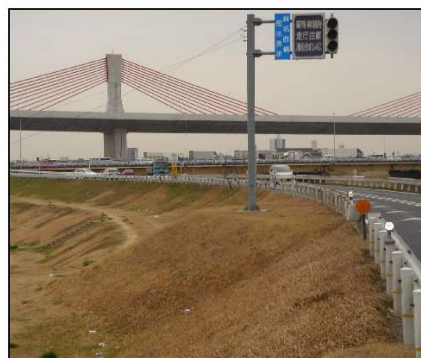
冠水表示板の計画堤防外設置 (庄内川左岸16.2k付近)
