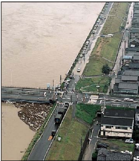
東海豪雨時の違法駐車状況 (庄内川右岸 4.0k 付近)
