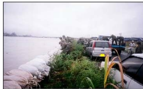
違法駐車車両が水防活動への支障 となる(庄内川右岸 4.0k 付近)
