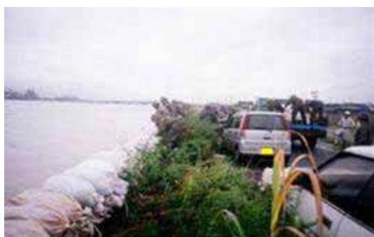
(庄内川右岸 4.0k 付近)
