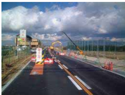
(庄内川右岸 12.0k 付近)
