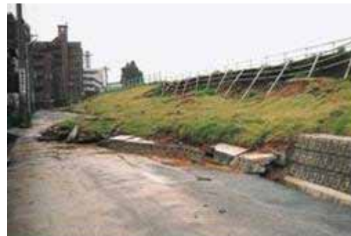
図4 川裏側法面崩壊
