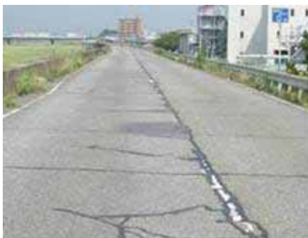
図3 舗装面の損傷(クラック)
