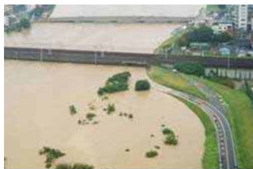
(庄内川左岸 14.2k 付近)
