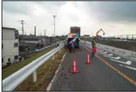
除草作業に伴う車線規制 (庄内川右岸13.4k付近)
