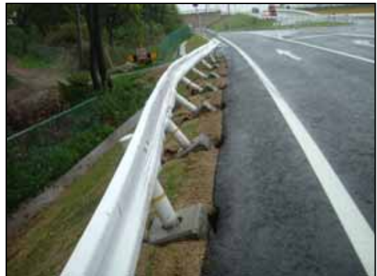
平成17年4月 庄内川左岸7.2k付近(中村区)
