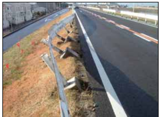
平成17年12月 庄内川左岸11.0k付近(中村区)
