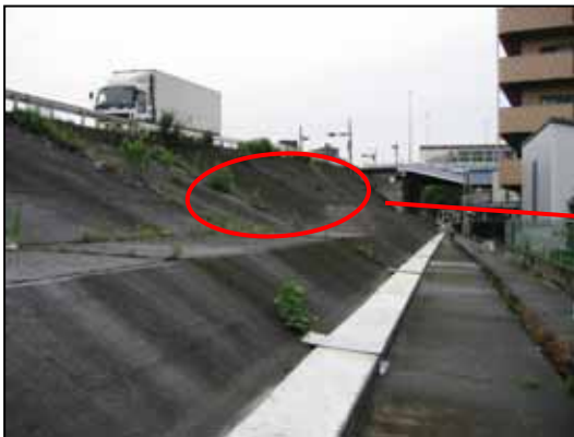
川裏側法覆工の損傷(庄内川左岸0.8k付近)
