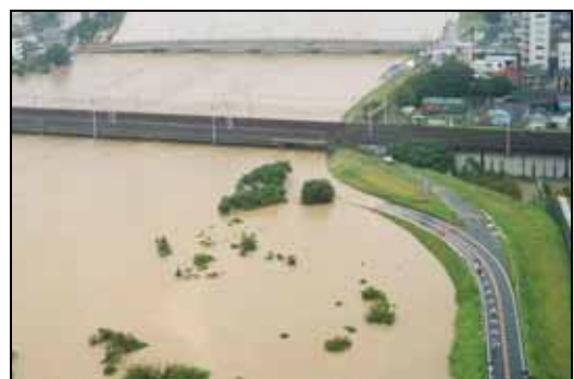
東海豪雨時における JR東海道本線枇杷島橋梁の 堤外アンダーパスの水没 (庄内川左岸14.2k付近)
