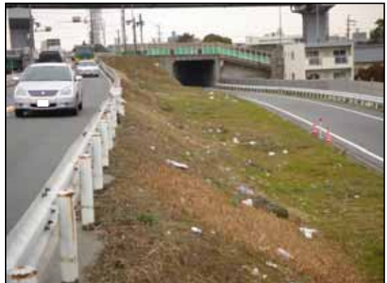
アンダーパス箇所でのポイ捨て状況 (庄内川左岸8.8k付近)
