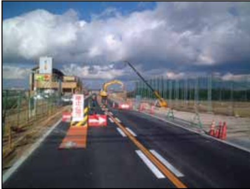
工事に伴う車線規制 (庄内川右岸12.0k付近)
