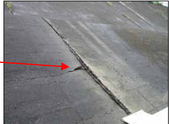
川裏側法覆工の損傷(庄内川左岸0.8k付近)
