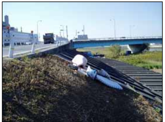
ゴミの不法投棄 (庄内川左岸10.4k付近)
