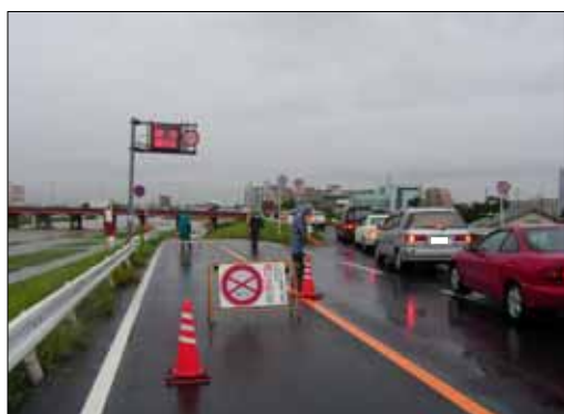
三階橋通行止めの状況 (矢田川左岸3.8k付近)
