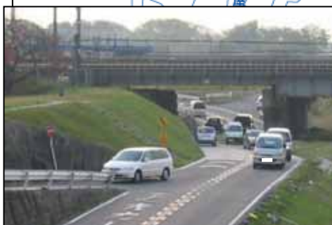
JR東海道本線枇杷島橋梁の堤外アンダーパス (庄内川左岸14.2k付近)
