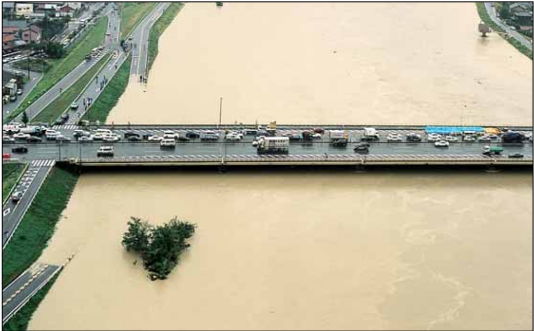
東海豪雨時における新名西橋堤外アンダーパスの水没(庄内川左岸16.0k付近)
