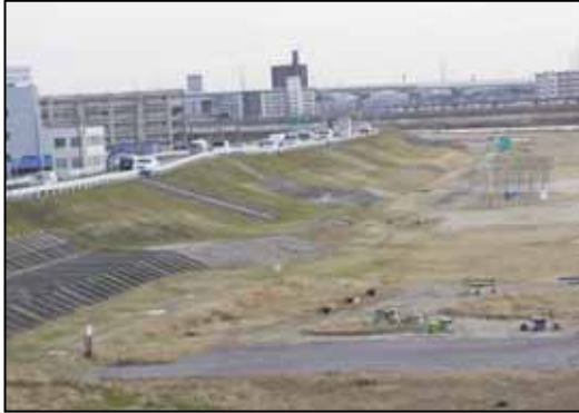
公園及び堤防道路の状況:大正橋緑地 (庄内川左岸10.0k付近)
