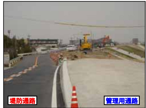
(庄内川右岸12.2k付近)
