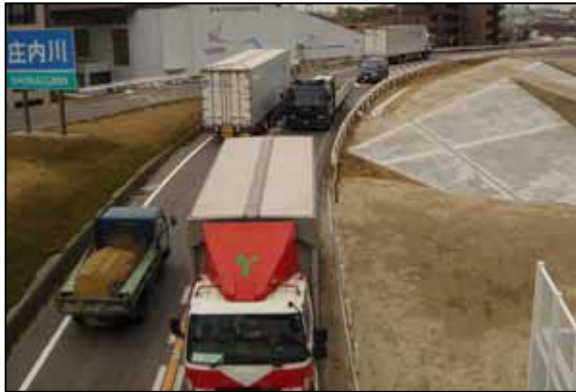
河川管理用通路の機能が優先されていない (庄内川左岸14.2k付近)
