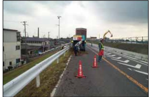
除草作業に伴う車線規制 (庄内川右岸13.4k付近)
