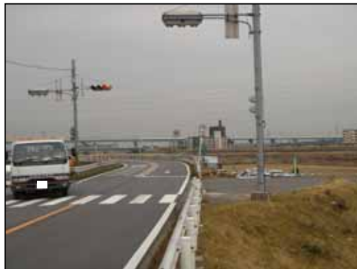
信号交差点からのアクセス:大正橋緑地 (庄内川左岸10.0k付近)
