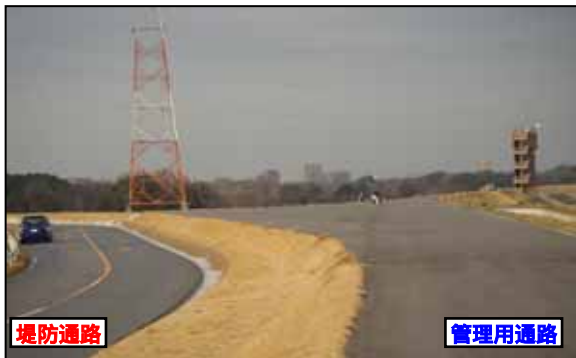
(庄内川右岸16.2k付近)
