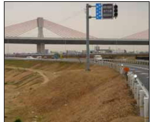
冠水表示板の計画堤防外設置 (庄内川左岸16.2k付近)
