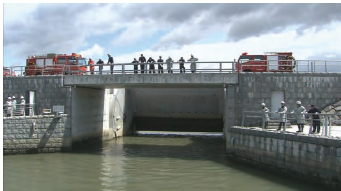
防潮扉の閉鎖
