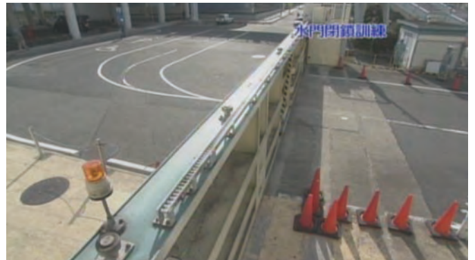
名古屋港陸閘閉鎖
