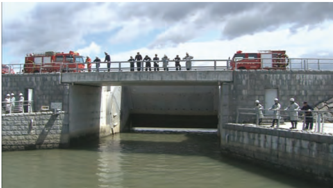
防潮扉の閉鎖
