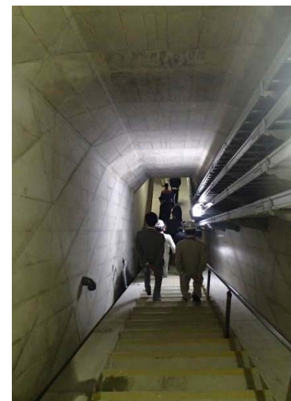
とても深いダムの監査廊
