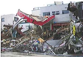
釜石市内(岩手県)被災状況
