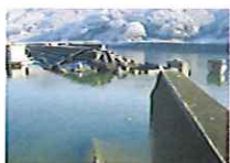
大槌川堤防(JR橋梁部)
