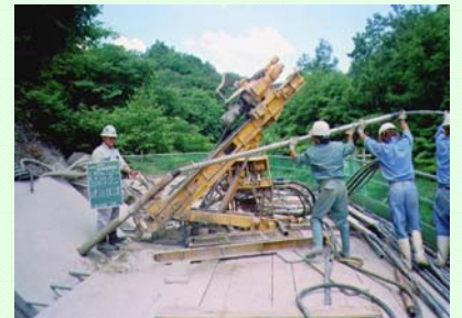
アンカー工事の様子
