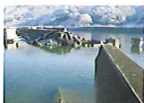
大槌川堤防(JR橋梁部)
