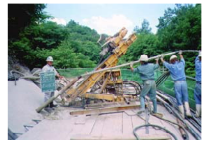
アンカー工事の様子
