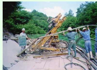
アンカー工事の様子
