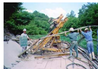
アンカー工事の様子
