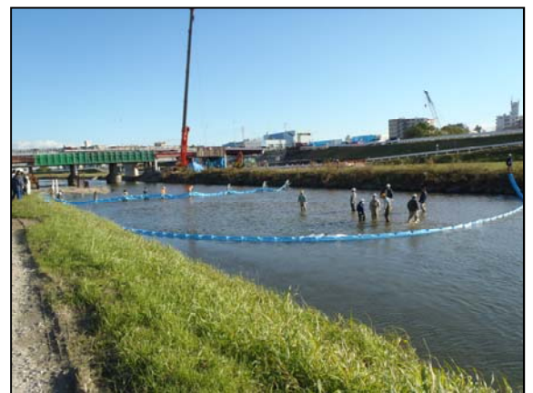
(川の中に入ってオイルフェンスを設置)
