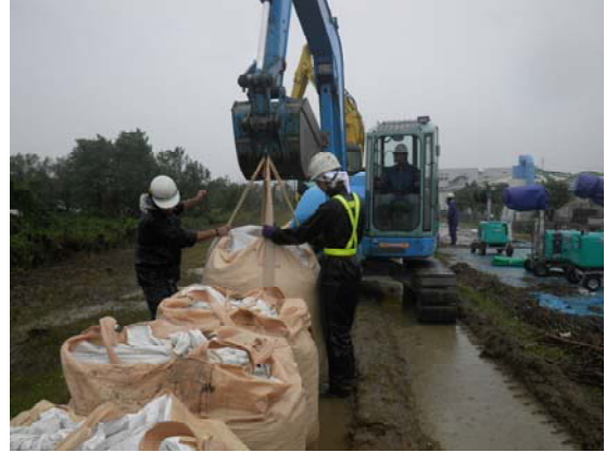
<土のう等の応急災害対応>
