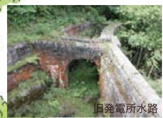
旧発電所水路
