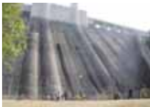
下流広場 ダムを真下から展望できる広場です。また、放流時には水の流が見学できます。
