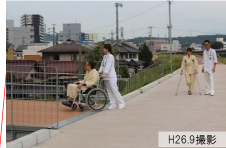
H26.9撮影 多治見市民病院と繋がるブリッジの利用状況
