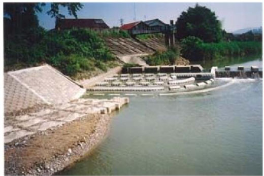
魚道改善箇所の事例 (高貝用水堰)
