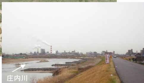
水制工の設置状況
