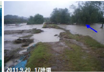
平成23年9月洪水（台風15号） 下志段見地区の越水状況
