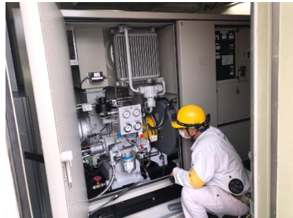
通信設備の点検状況
