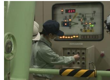
ゲート操作状況
