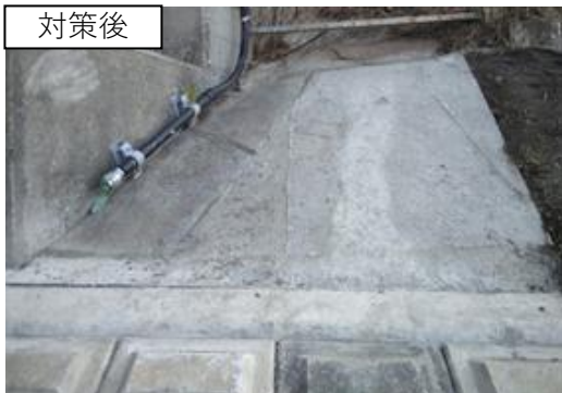
護岸の破損・損傷を修繕
