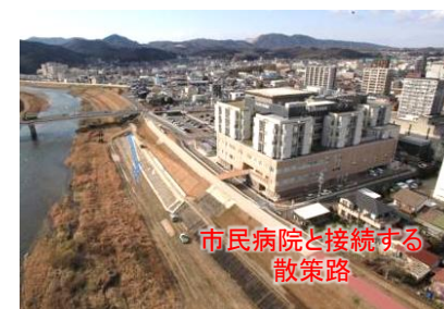
豊岡地区水辺整備
