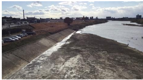
樹木伐採の状況(左岸15.8k付近)
