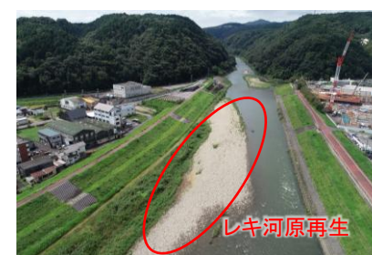
庄内川上流部自然再生
