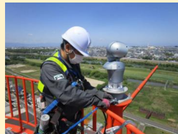
通信設備の点検状況
