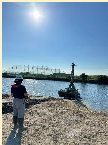
遠隔操縦による施工状況
