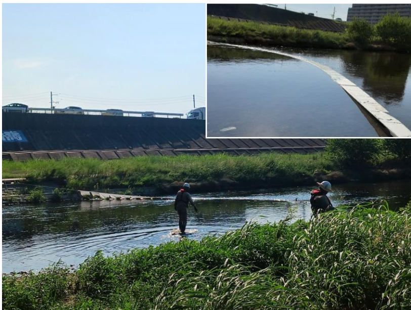
オイルフェンスによる水質事故対応
