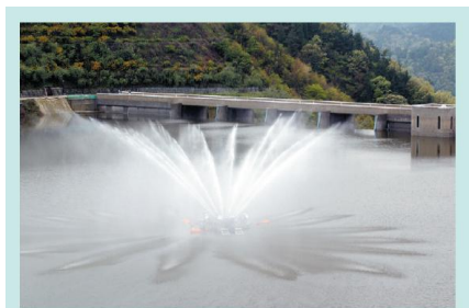
●小里川表層循環設備 ダム表層の水を噴水などで乱すことにより、ダム湖内でのアオコの発生を防ぎます。
