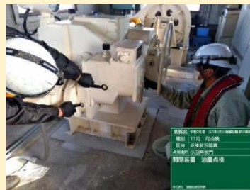
機械設備の点検状況
