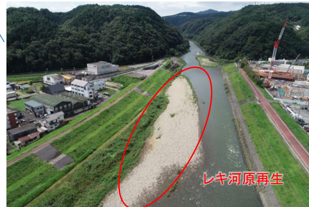
庄内川上流部自然再生
