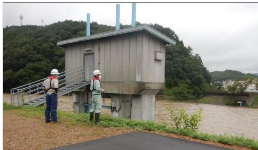
出水時の巡視（施設状況確認）
