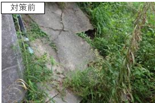
護岸の破損・損傷
