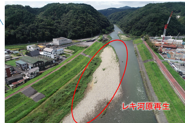
庄内川上流部自然再生
