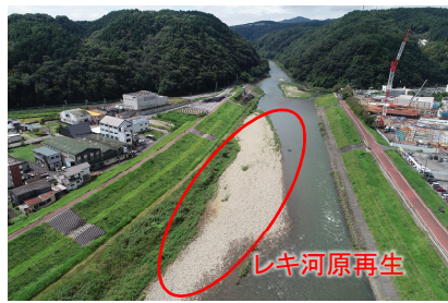
庄内川上流部自然再生
