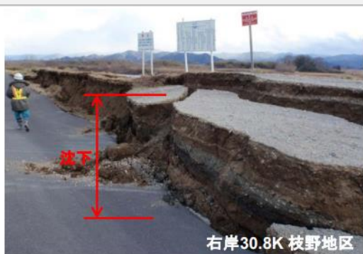
液状化により堤防が約2~3m沈下
