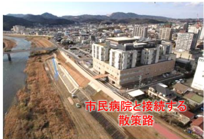
豊岡地区水辺整備
