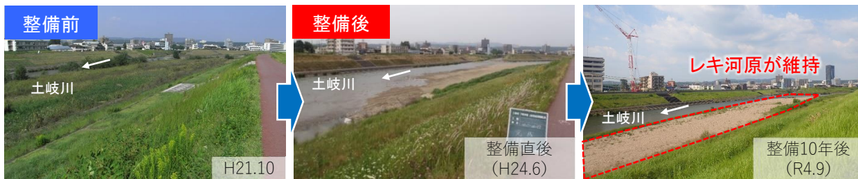
国長橋下流 (47.6k下流左岸) での整備実施状況
