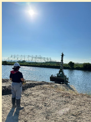
遠隔操縦による施工状況
