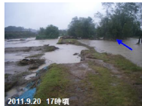
平成23年9月洪水（台風15号） 下志段見地区の越水状況
