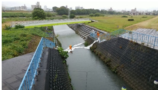
矢田川(守山川排水樋門)
