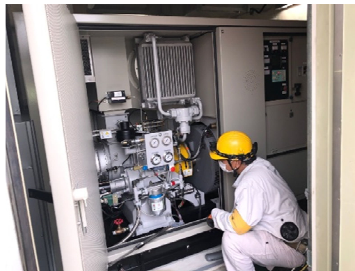
通信設備の点検状況
