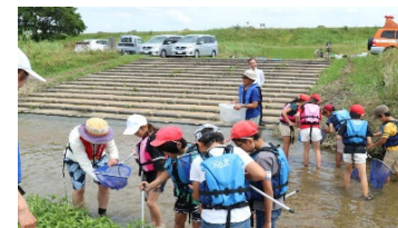
親水施設整備(階段護岸)
