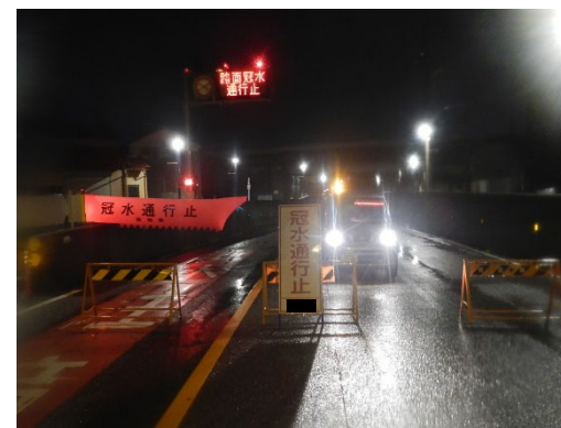
堤防道路における出水時通行規制
