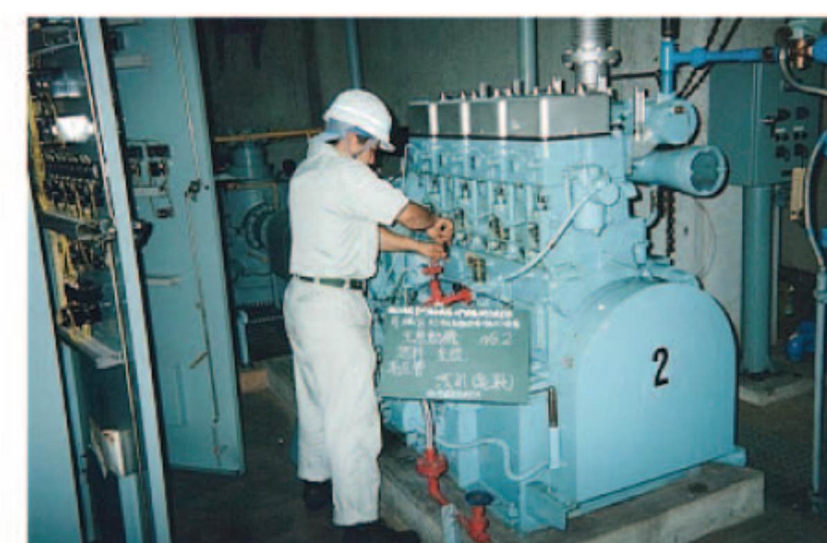
排水機場の点検
