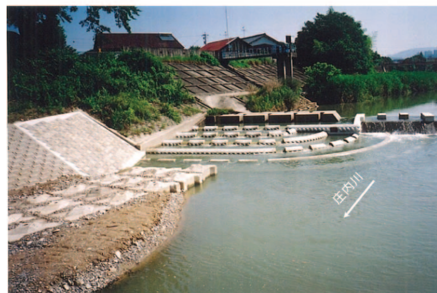
高貝用水堰の魚道（魚道改善箇所の事例）
