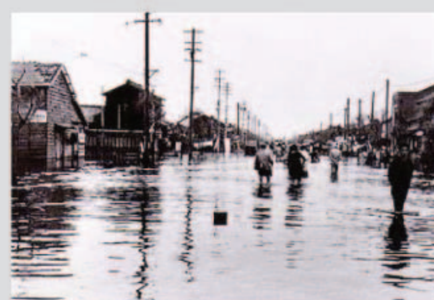
昭和34年9月伊勢湾台風の被害の様子(名古屋市港区)
