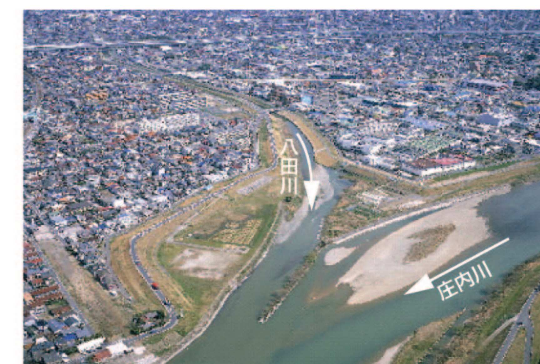
排水の影響が見られる八田川合流部
