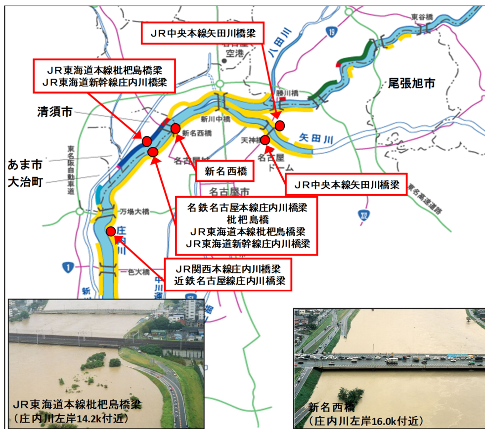
図 2-6 東海豪雨時の橋梁状況
