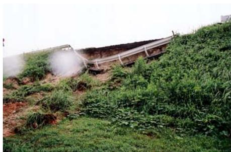
写真 2.1.6 堤防の不安定化、損傷
