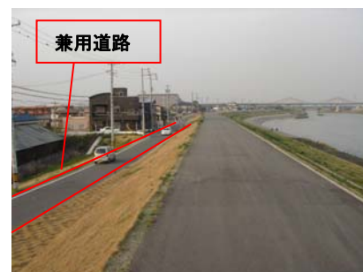
写真 4.3.3 管理用通路と分離し道路を小段に設置した事例(庄内川右岸 14.8k 付近)
