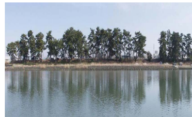
堤防法面に連なる樹齢200年近くのクロマツ並木の歴史的景観
