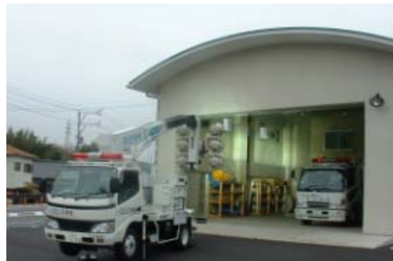
土岐防災センター (56.3k 右岸付近)
