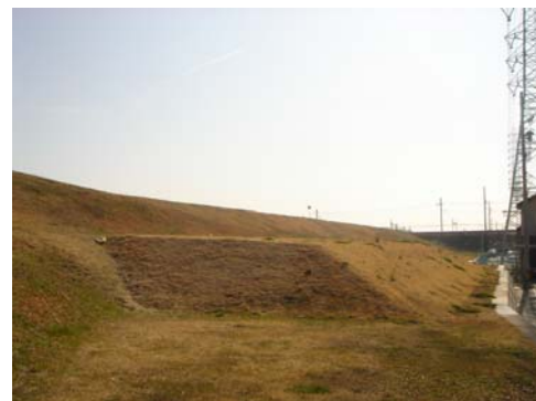
第二種側帯 (7.0 km 右岸付近)
