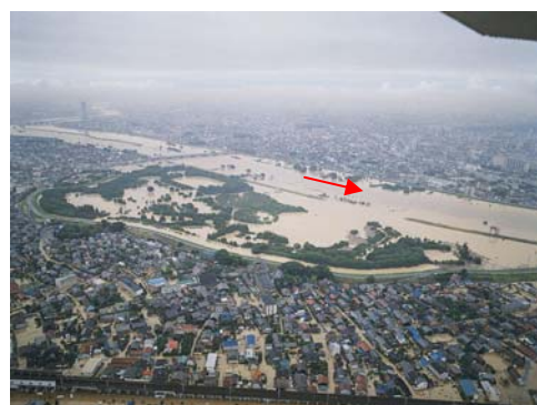
洪水時(撮影：平成 12 年 9 月洪水)
