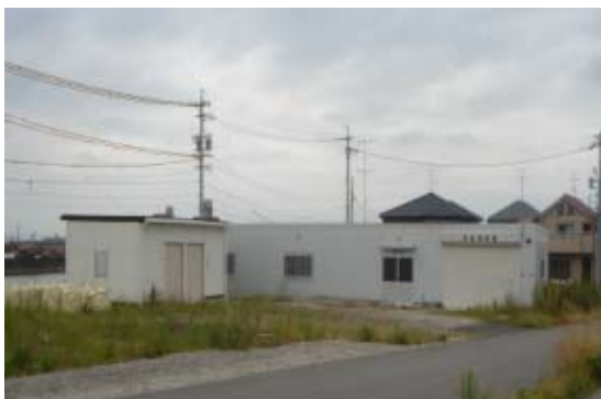
下之一色水防拠点 (3.4k 右岸付近)
