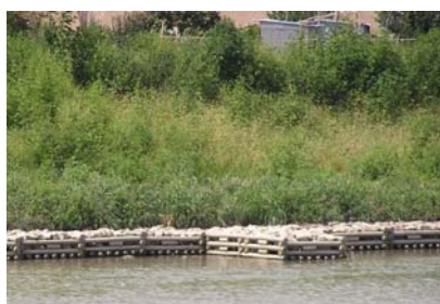
河道掘削時における水際部の環境配慮の事例
