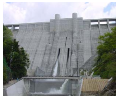
写真 4.3.1 小里川ダムの管理
