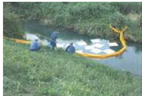
写真 2.1.26 水質事故対策 (オイルフェンス、オイルマット)
