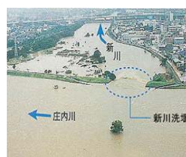
(新川洗堰（河口から約19.3km付近）)
