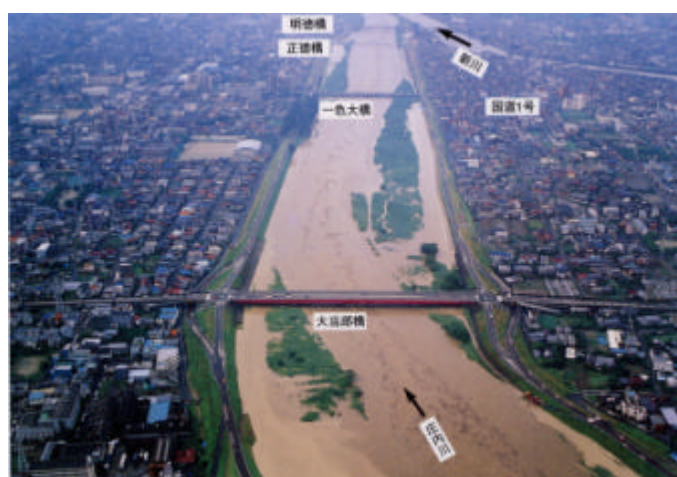
一色大橋(河口から約 4.4k)付近(名古屋市中川区)の状況
