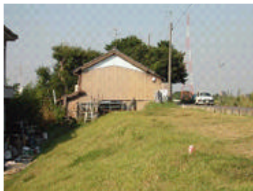
図-4.23 高水敷上の占用家屋
