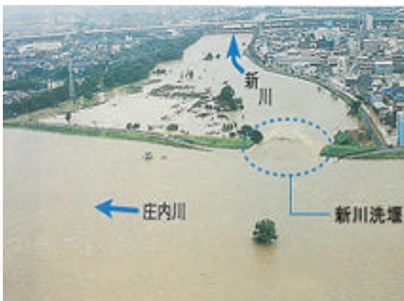
図-4.15 新川洗堰(河口から約 19.3k)付近
