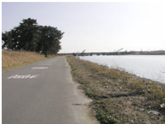
図-7.12 緊急河川敷道路
