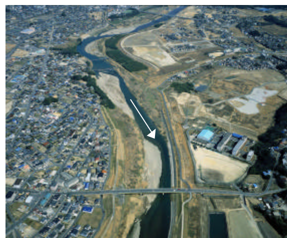
野添川合流付近(33.0k 付近)
