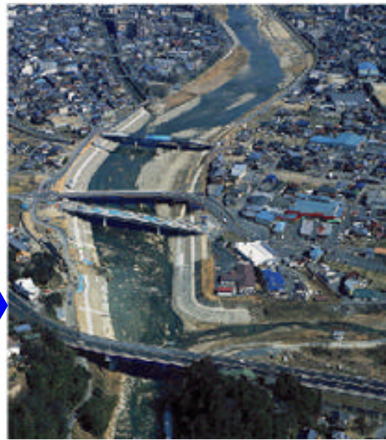
(対策後 平成16年3月撮影)
