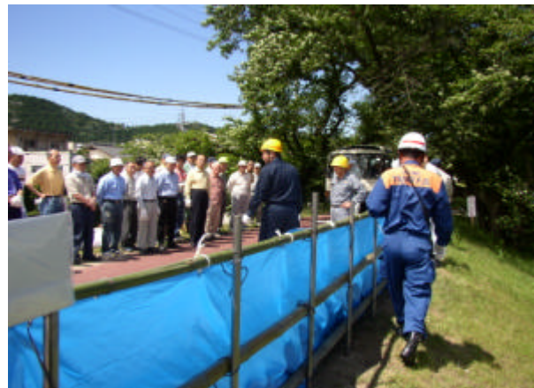
地元住民で作成したシート張り工法
