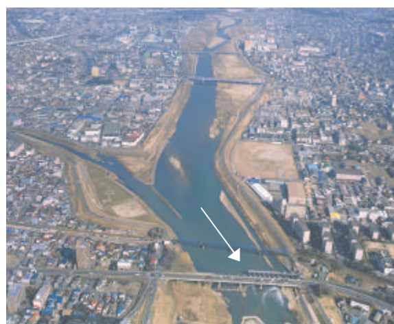
八田川が合流する水分橋付近(24.0k 付近)
