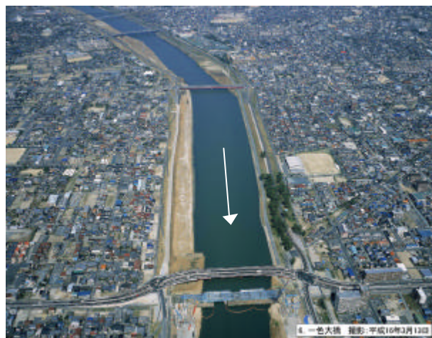
一色大橋 (4.5k 付近)
