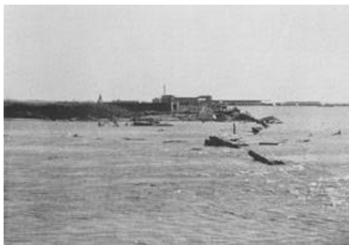
伊勢湾台風による宝神町地内破堤状況
