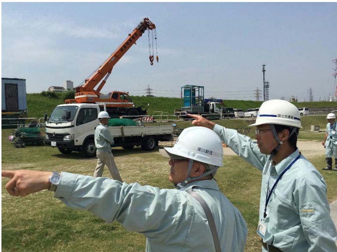
▲トイレ施設をクレーンで搬出
