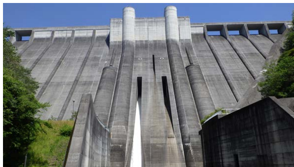
▲常用洪水吐からの放流（R1.5.10 撮影）
