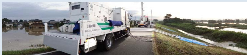
『平成27年9月関東・東北豪雨』鬼怒川決壊に伴う浸水箇所で活動中の排水ポンプ車及び照明車
