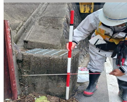
河川巡視 堤内地浸水状況の確認
