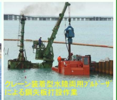
クレーン装着型水陸両用ブルドーザによる鋼矢板打設作業
