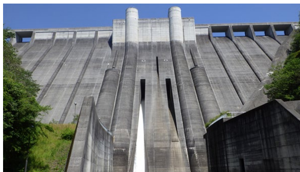
▲常用洪水吐からの放流（R1.5.10撮影）
