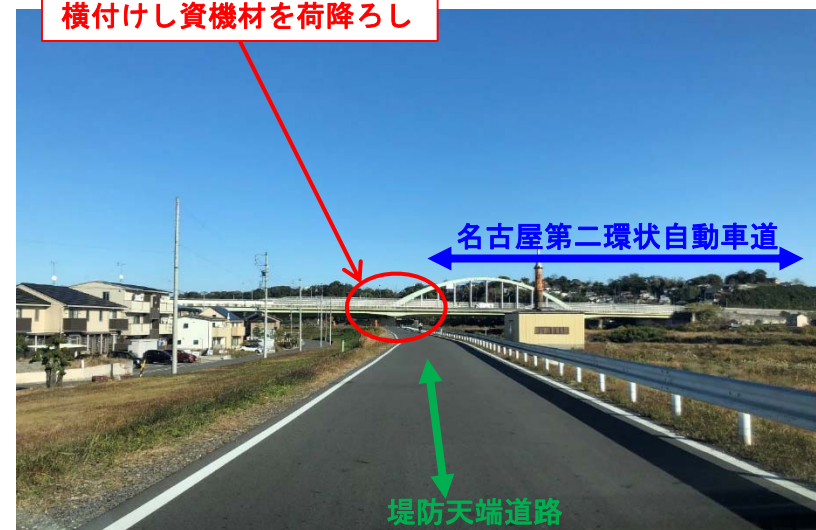
高速道路と堤防天端道路の立体交差部 (写真上：庄内川左岸19.4k+202m付近 写真下：庄内川右岸32.4k-86m 付近)
