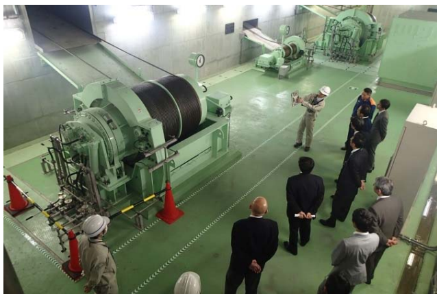
ダム内部のゲート設備を見学
