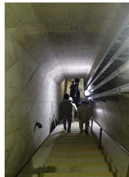
とても深いダムの監査廊
