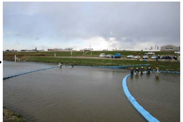
(川の中に入ってオイルフェンスを設置)
