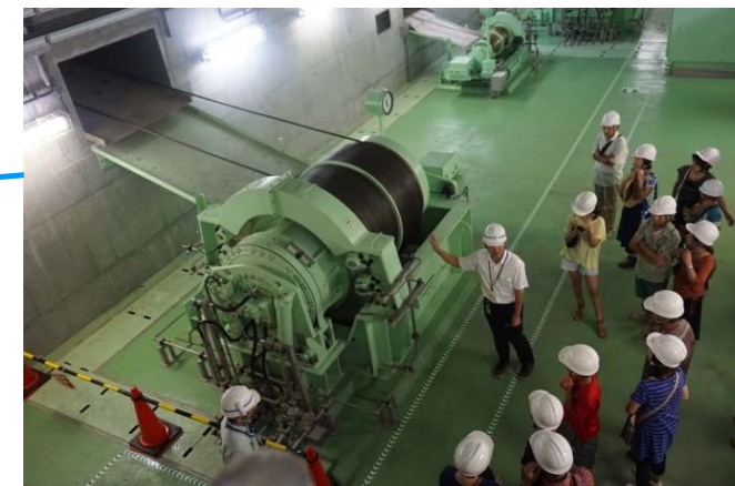
巨大なゲートの巻き上げ機を見学
