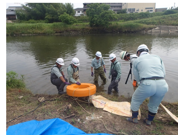
写真⑥:ポンプを河川へ投入状況
