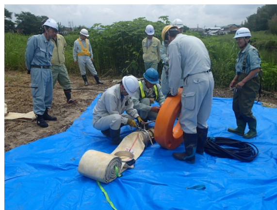
写真⑤:排水ホース設置状況
