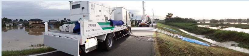
『平成27年9月関東・東北豪雨』鬼怒川決壊に伴う浸水箇所で開催中の排水ポンプ車及び照明車
