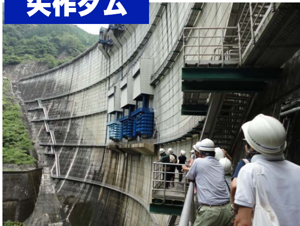
ダム内部を通り抜けると、堤体が目の前に 迫り来るアーチ式コンクリートダム
