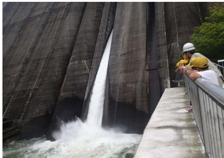
出水期に備えた水位低下放流の様子
