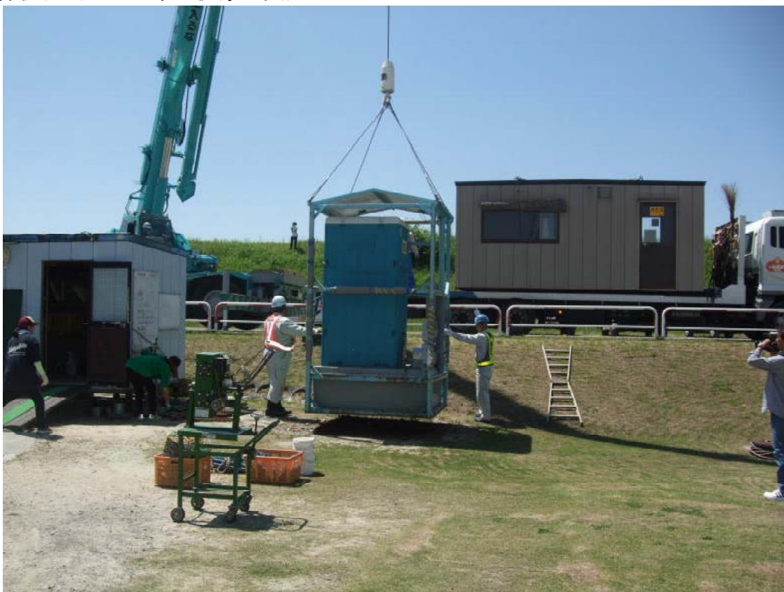
▲トイレ施設，ユニットハウスの搬出
