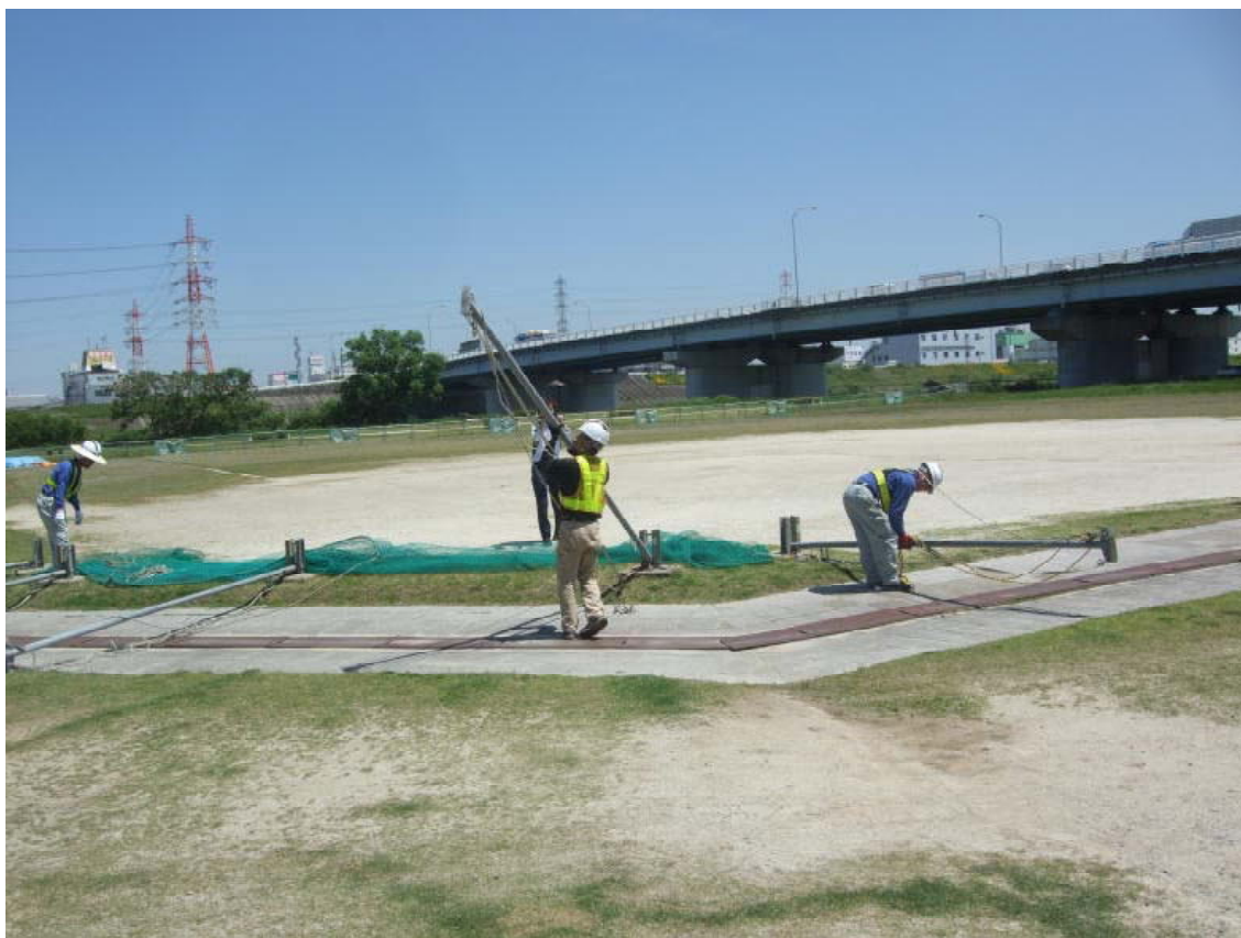
▲野球場ネット用支柱の転倒
