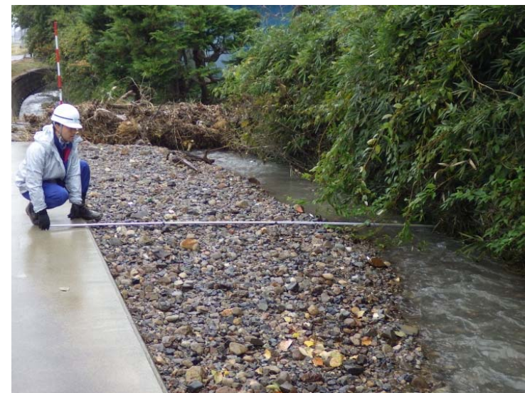
被災状況調査状況 （清水川 25日降雨後の再調査）
