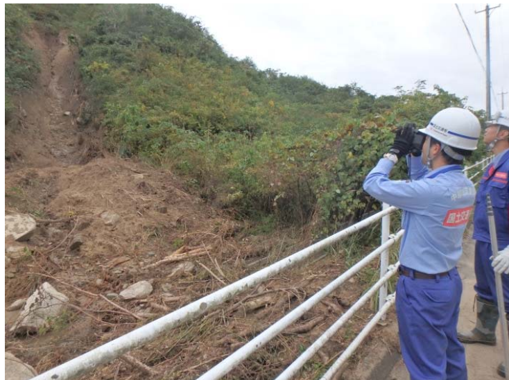
被災箇所調査状況 （小坂川 25日降雨後の再調査）
