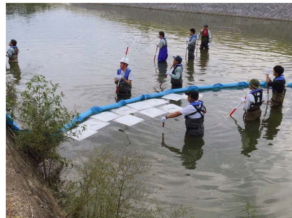
【オイルフェンス・オイルマットの設置】
