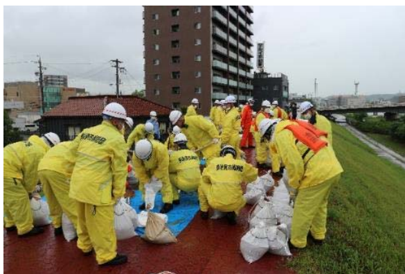
「積み土のう工法」の実施状況
