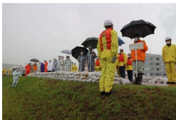
「積み土のう工法」を巡視する 古川多治見市長と来賓
