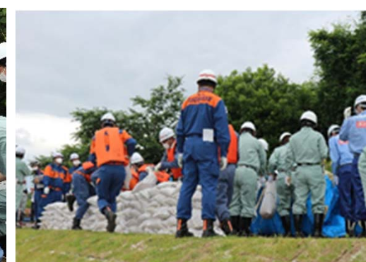
積み土のう工法実施状況
