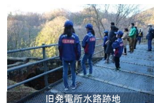
旧発電所水路跡地
