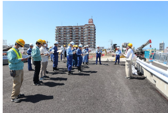
枇杷島橋迂回路仮橋の現場を巡視
